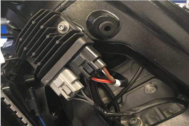
Image 9: Générateur sur la section avant gauche du cadre principal..
